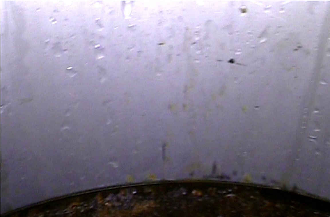
Dybde: 1,92 meter under terræn. Overgang fra stålrør til rustfrie stålrør.
