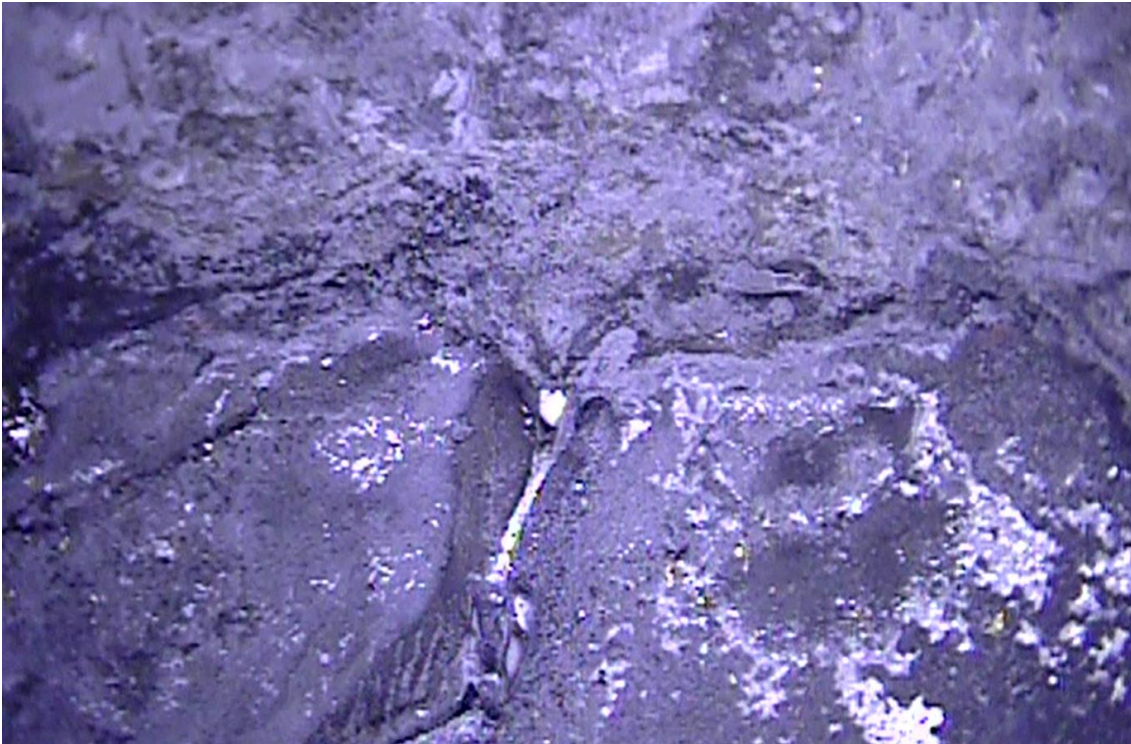
Dybde: 28,34 meter under terræn. Bund af boresko.
