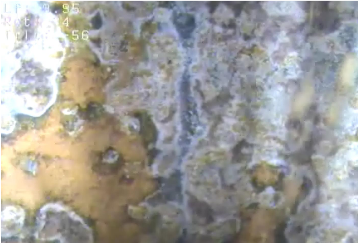
Dybde: 9,95 meter under terræn. Store okkerbelægninger. Meget okker svæv i vandet.
