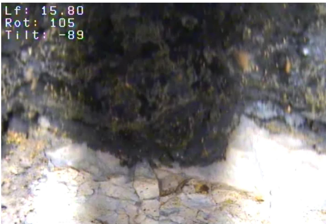
Dybde: 15,80 meter under terræn. Bund af boresko.
